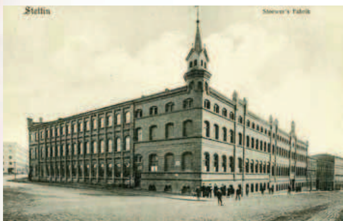
Fabryka Stoewera na Niebuszewie, początek XX wieku
